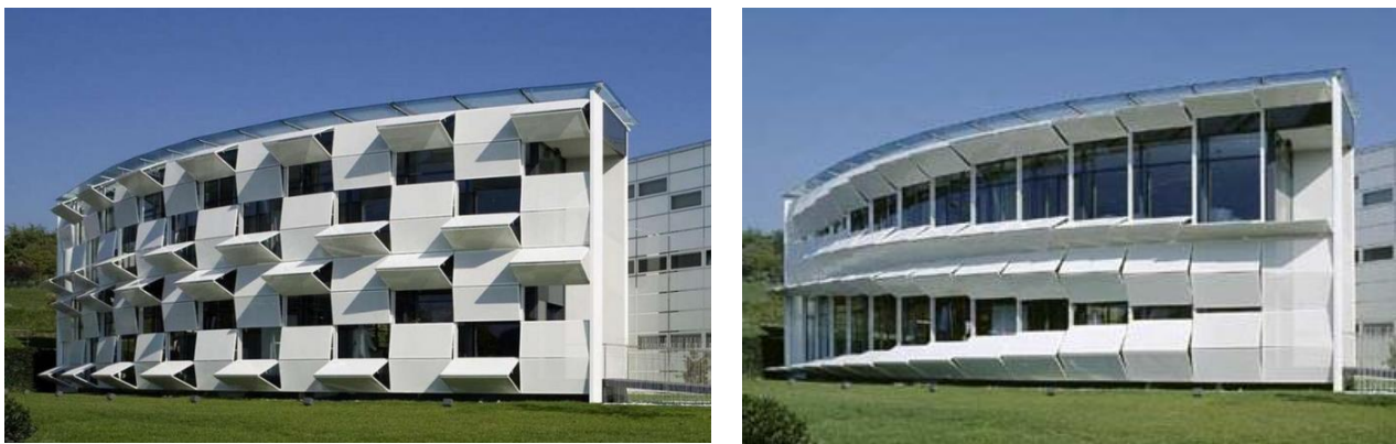
Рис. 1. Здание с динамическим фасадом от Эрнст Гизельбрехт
