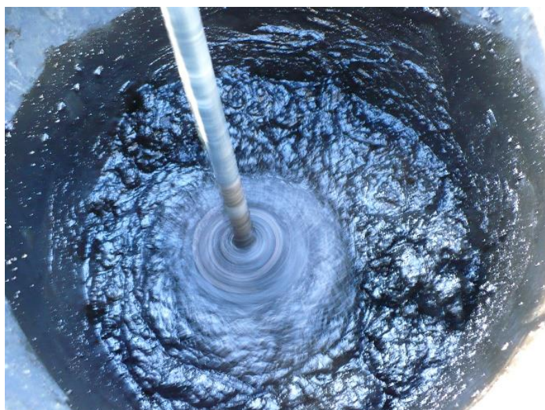
Рис. 2. Приготовление гидрофобного состава вручную
