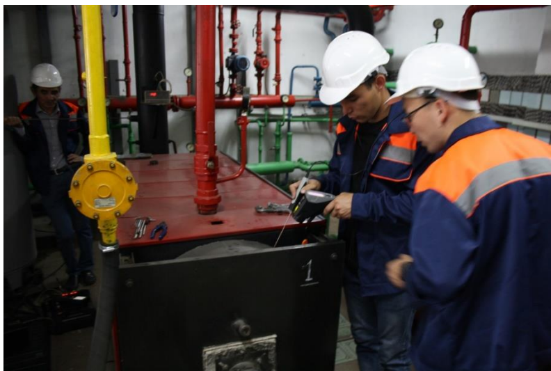
Рис. 1. Процесс измерения температуры наружной стенки котла
