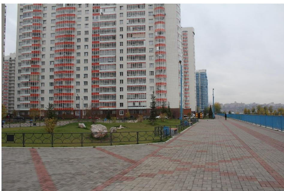
Рис. 2. Агрессивные поля, сформированные фасадом и покрытием
