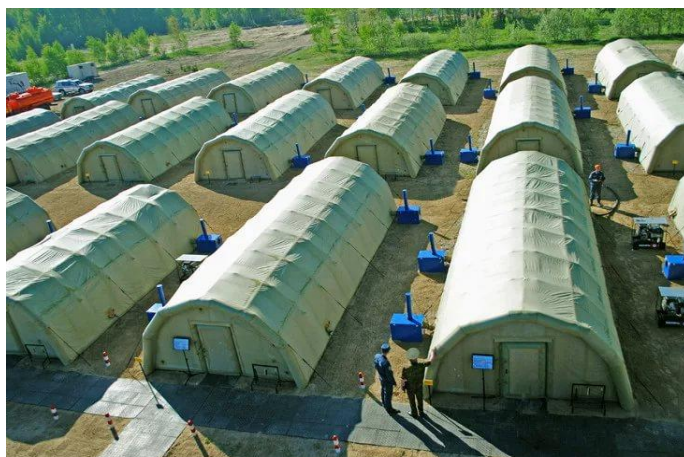
Рис. 1. Военный госпиталь из пневматических сооружений
