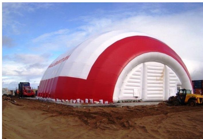
Рис. 4. Пневмоарочные сооружения для хранения техники в Московской области
