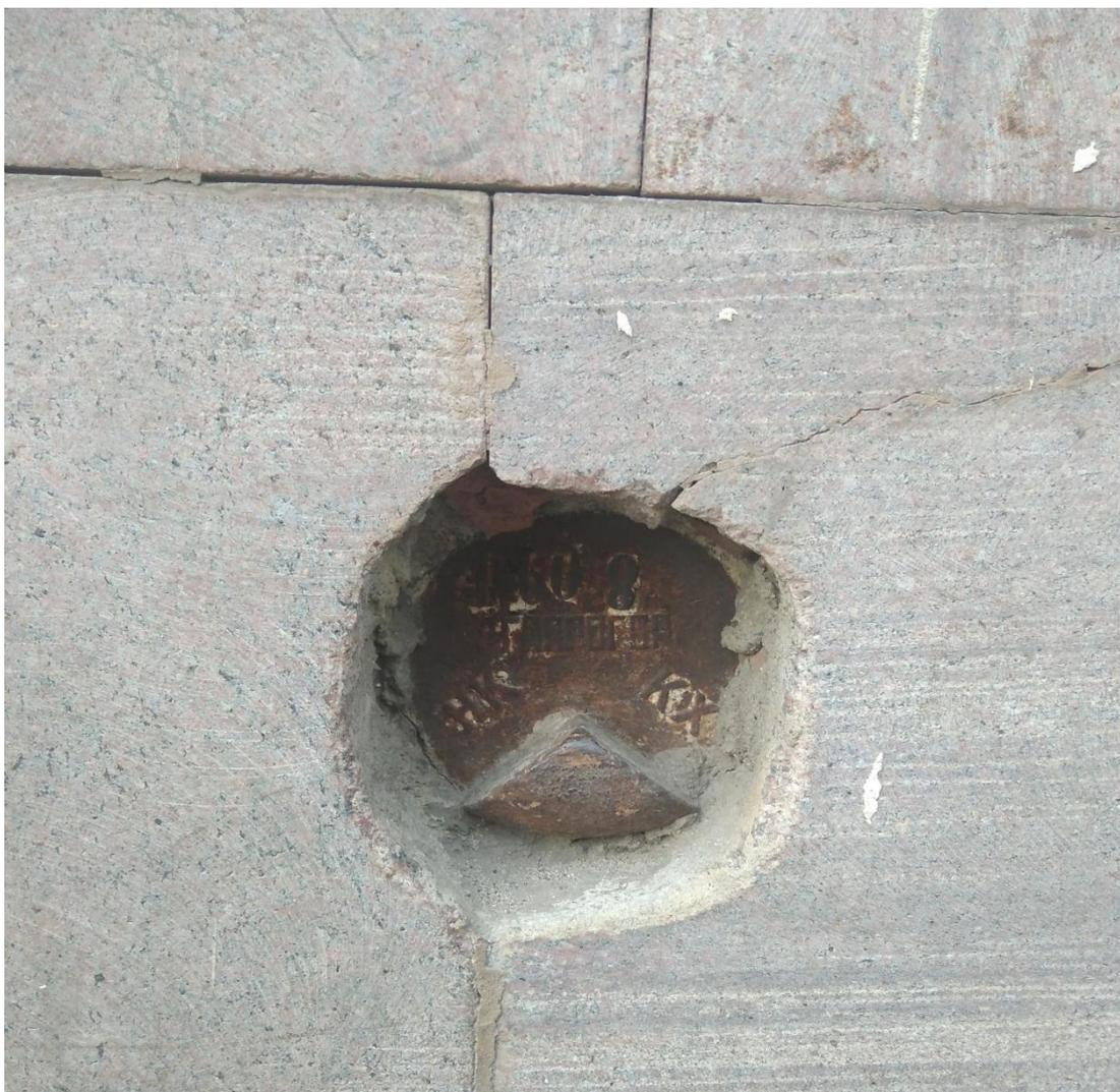
Рис. 3. Стенной репер.
